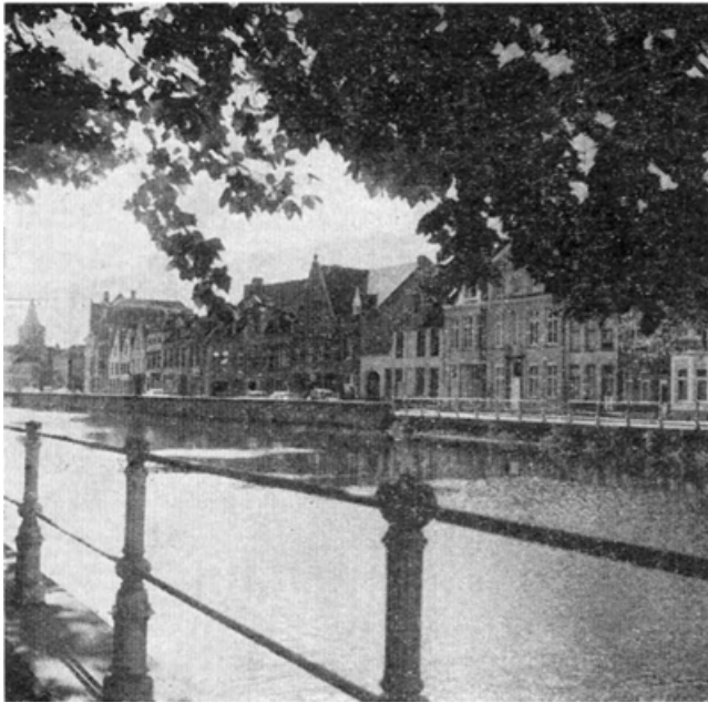
De Langerei, met poortingang van de velleploterie De Jonghe. Brugge 1974.
