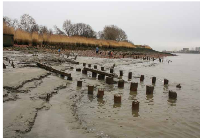
Een vergelijking van foto's van de linker Scheldeoever nabij het vroegere Sint-Annadorp toont dat door o.a. oevererosie houten structuren tevoorschijn komen. Hier is de blootspoeling zichtbaar van de restanten van een kadeconstructie of scheepshelling op 18 april 2018 (links) en 10 januari 2019 (rechts)
