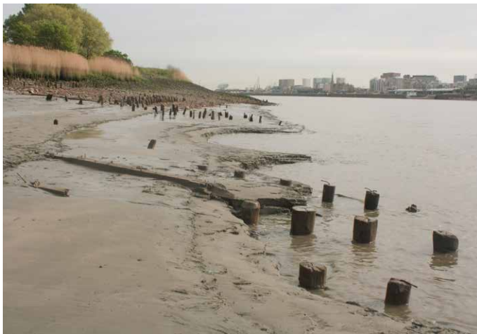
Een vergelijking van foto's van de linker Scheldeoever nabij het vroegere Sint-Annadorp toont dat door o.a. oevererosie houten structuren tevoorschijn komen. Hier is de blootspoeling zichtbaar van de restanten van een kadeconstructie of scheepshelling op 18 april 2018 (links) en 10 januari 2019 (rechts)
