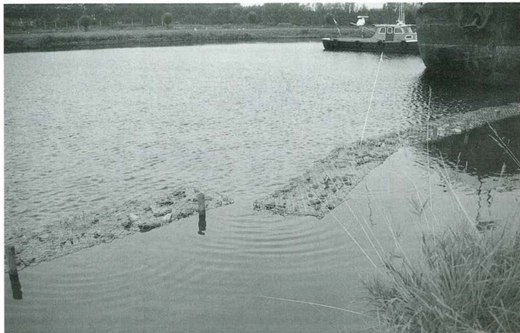
Aanleg van vooroeververdediging met schanskorven in de Overijsselsche Vecht. (Bekker)
