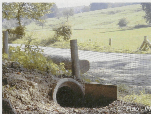
Dassentunnel : een fijnmazig en ingegraven raster verhindert de dassen de weg over te steken en een tunnel leidt hen veilig naar de overkant.
