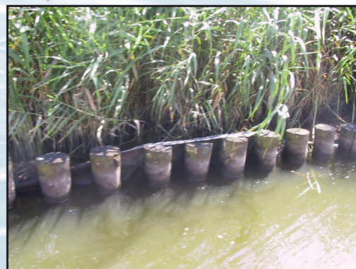
Foto 6: Enkele palenrij, onder water gestut met schanskorven en Riet aangeplant op kokosrollen. Geotextiel is zichtbaar op deze foto.
