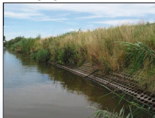
Foto 6: Enkele palenrij, onder water gestut met schanskorven en Riet aangeplant op kokosrollen. Geotextiel is zichtbaar op deze foto.
