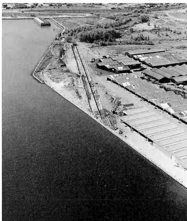
Foto 2. — De gronden ter hoogte van Kaai 57 en ter hoogte van het geplande wachtdok vóór de aanvang der werken.
