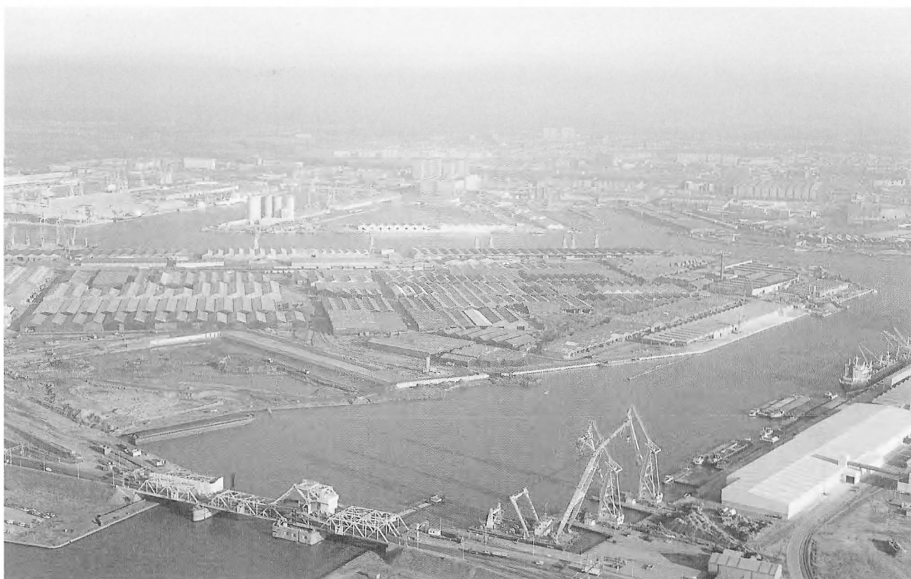
Foto 1. — Op de voorgrond de Noordkasteelbruggen met het toekomstige Wachtdok voor Lichters en de gronden van Kaai 57 die reeds gedeeltelijk werden afgevoerd. Op de achtergrond het Eerste Havendok en het Oude Schuildok voor Lichters.
