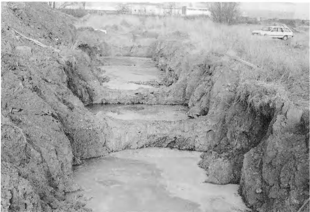
Foto 3. — Eén van de verkenningssleuven die gegraven werden om een duidelijk beeld van de ondergrond te bekomen. Sleuf 1.
