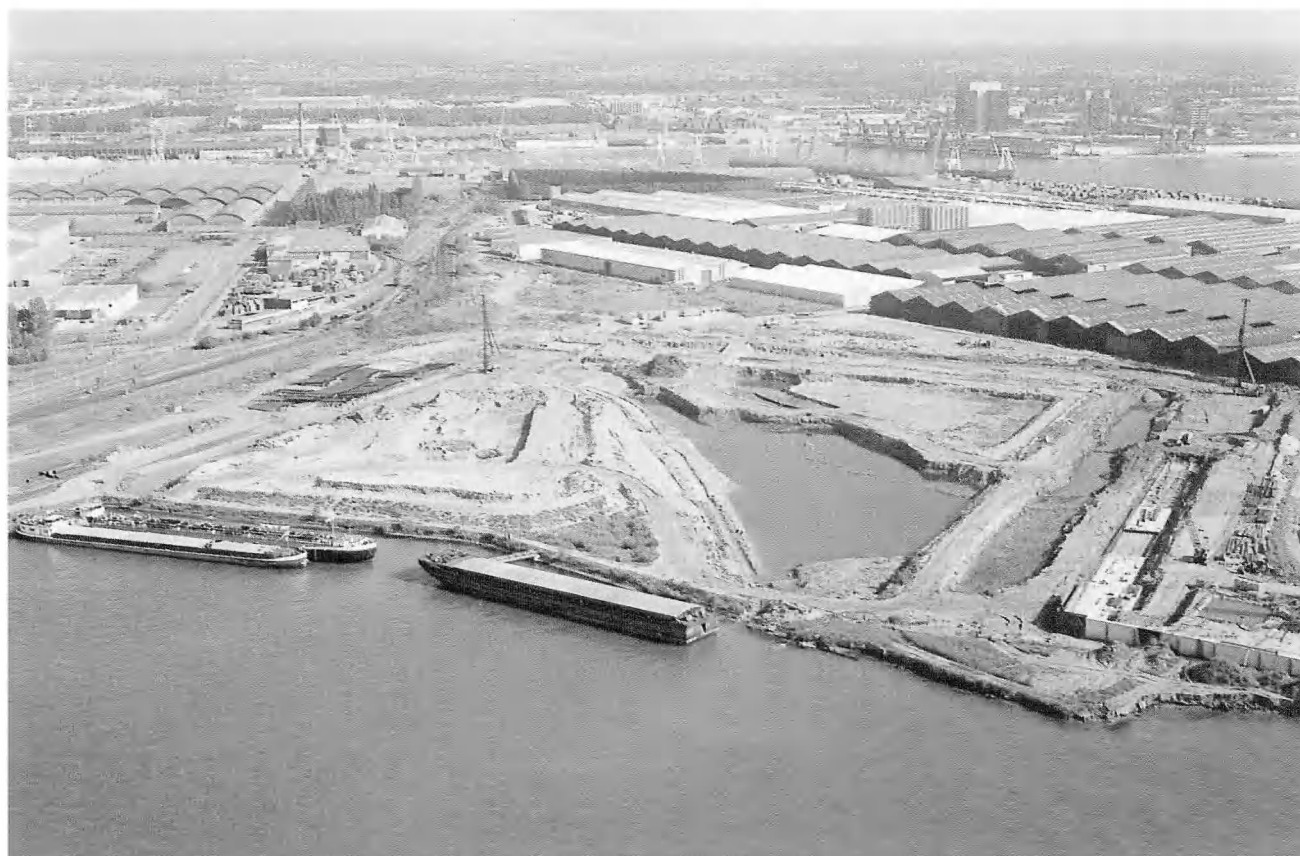
Foto 19. — Het geplande wachtdok werd systematisch volgens vooraf bepaalde zones uitgegraven.
