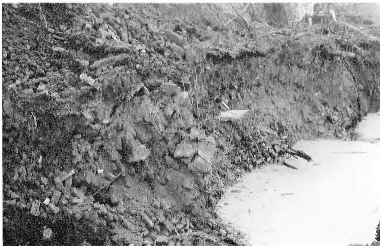
Foto 4, 5. — Bij het graven van de sleuven kwam er allerlei materiaal vrij: bakstenen, autobanden, bouwpuin,...
