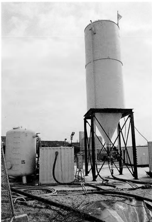
Foto 11. — Waterzuiveringsinstallatie 1e trap: ozonatie.
