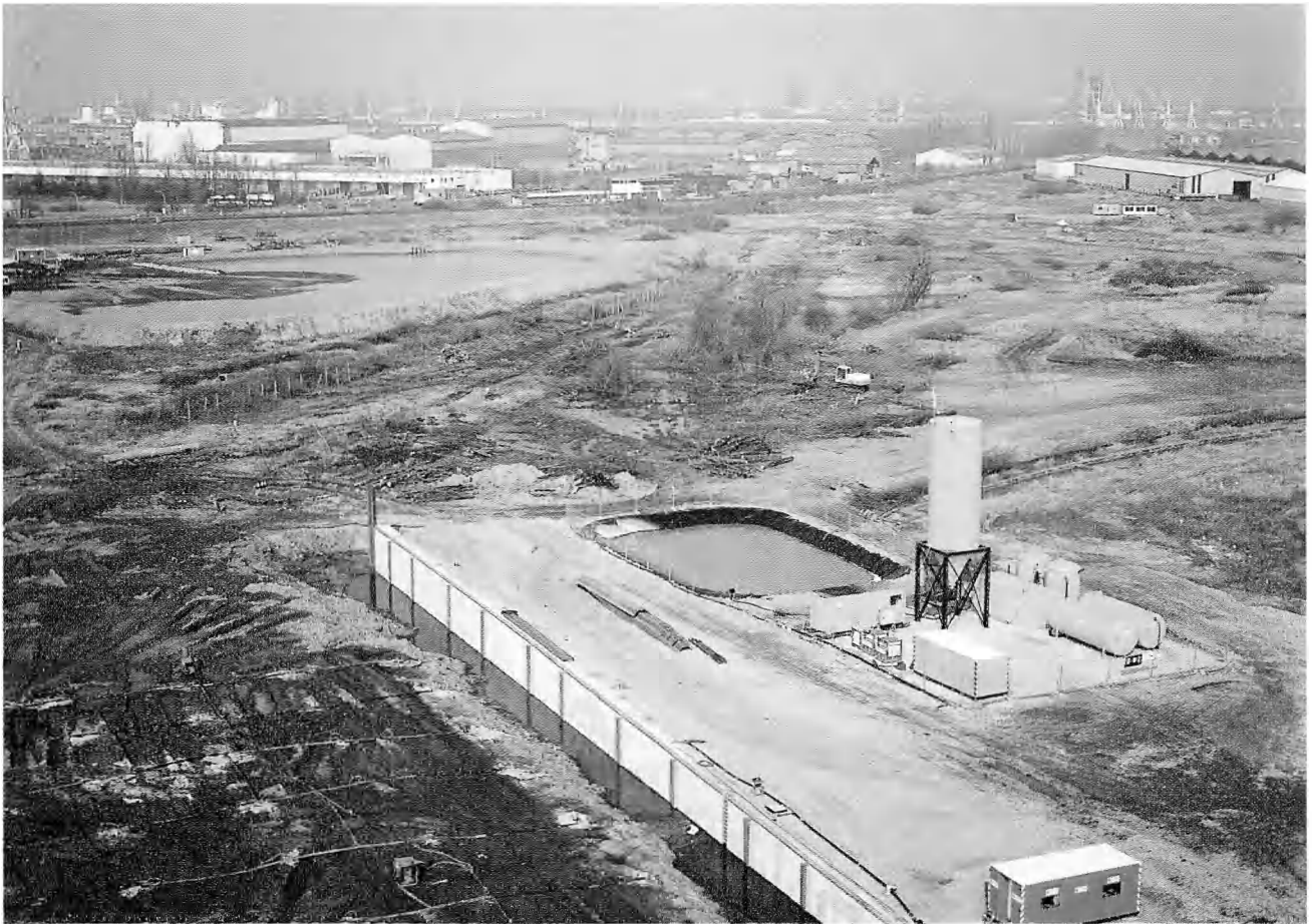
Foto 9. — Op de voorgrond de mobiele waterzuiveringsinstallatie en een deel van de af te graven gronden van kaai 57. Op de achtergrond de gronden ter hoogte van het geplande wacht dok voor lichten.
