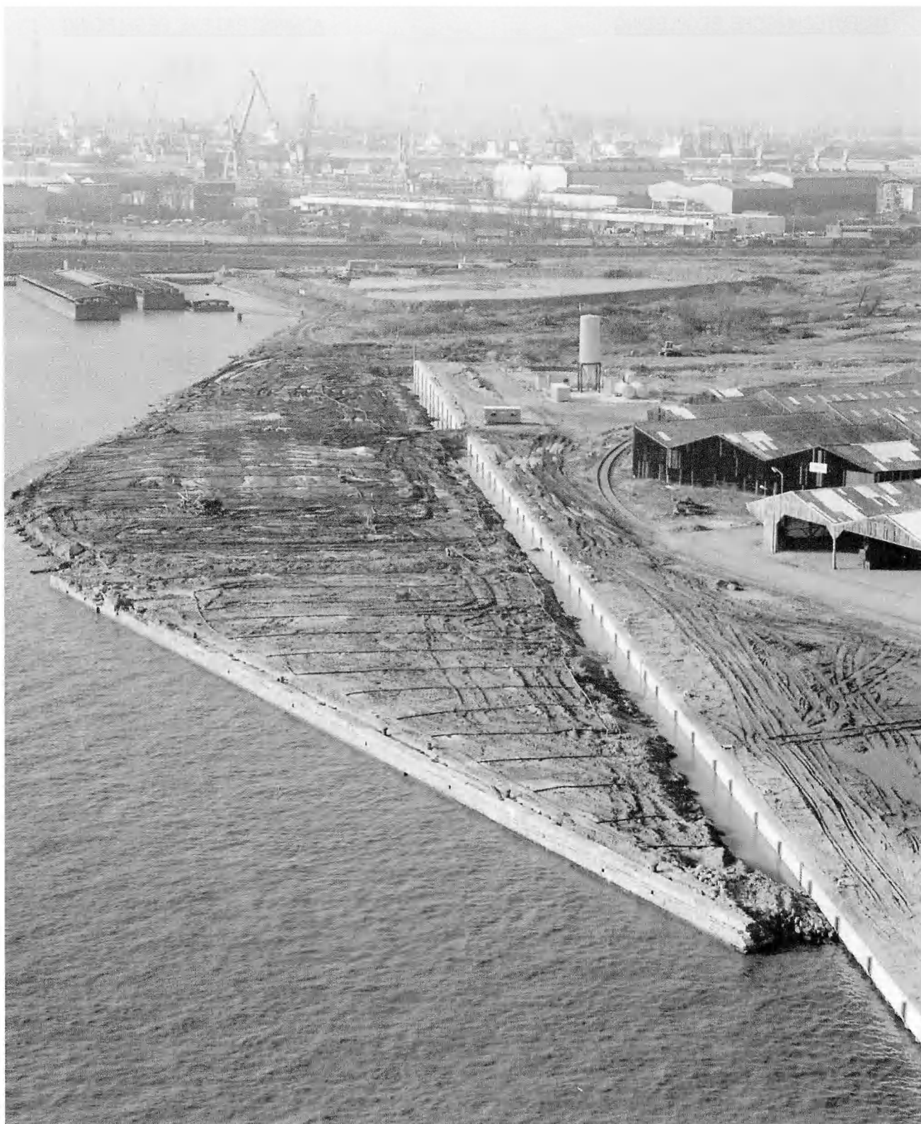
Foto 6. — Een zicht op de 269 bemalingsfilters ter hoogte van kaai 57 die aangesloten zijn op 8 batterijen om het water naar de waterzuiveringsinstallatie te pompen.
