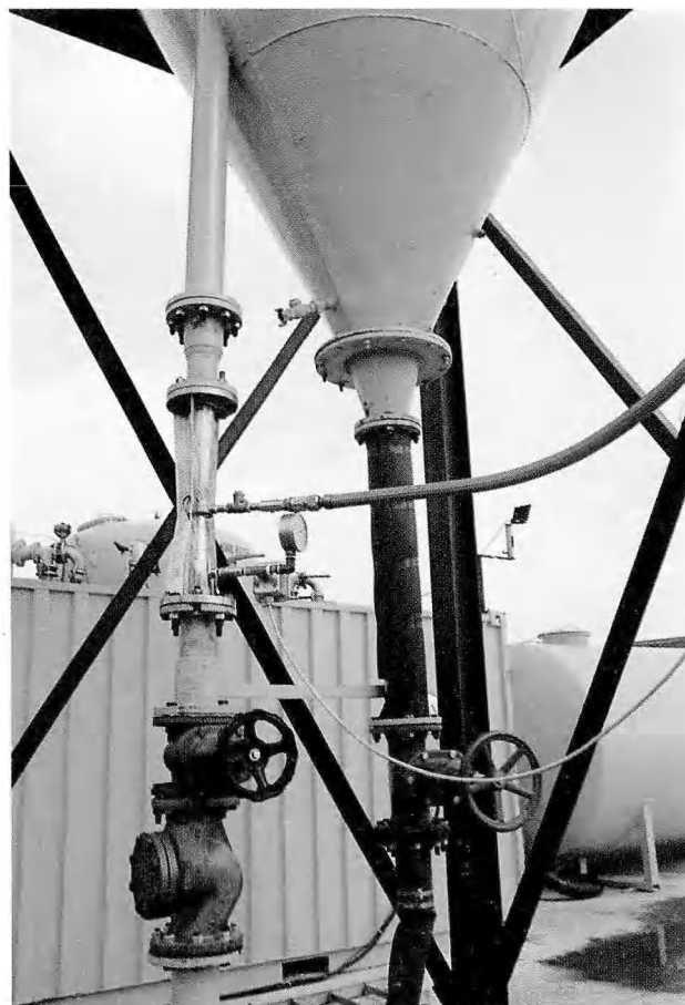
Foto 12. — Waterzuiveringsinstallatie 1e trap: ozonatie.
