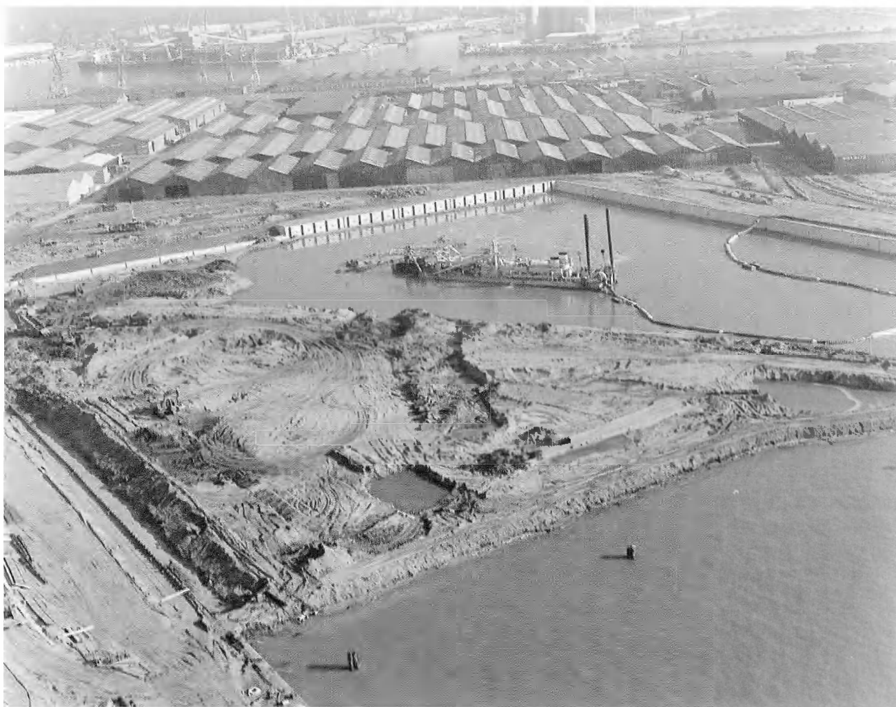
Foto 25. — De verzadigde gronden worden via het cutterprocédé afgevoerd. De cutterzuiger „Ortelius” is hier aan het werk ter hoogte van het nieuw te bouwen wachtdok.
