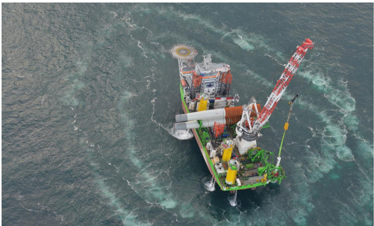
Voor het verminderen van de geluidsdruk tijdens het heien van funderingen in de zeebodem wordt onder meer een dubbel bellengordijn gebruikt (5 november 2019).
