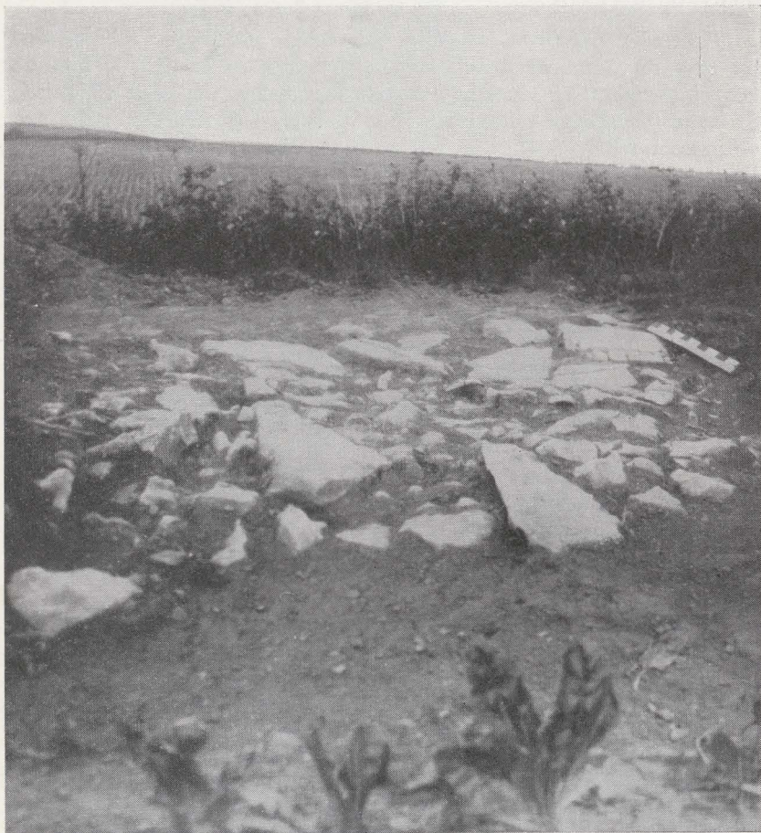
Fig. 20. — Dallage supérieur de la route Tongres-Arlon à Bonsin.
