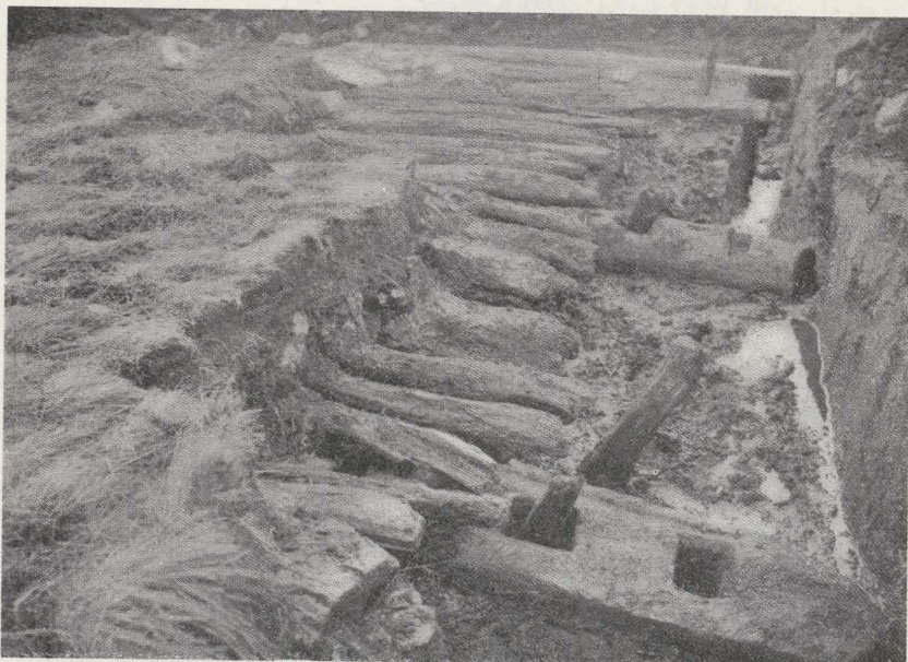
Fig. 23. — Détails de l'infrastructure en bois de la Via Mansuerisca. (d'après l'Ant. Class. 1934).
