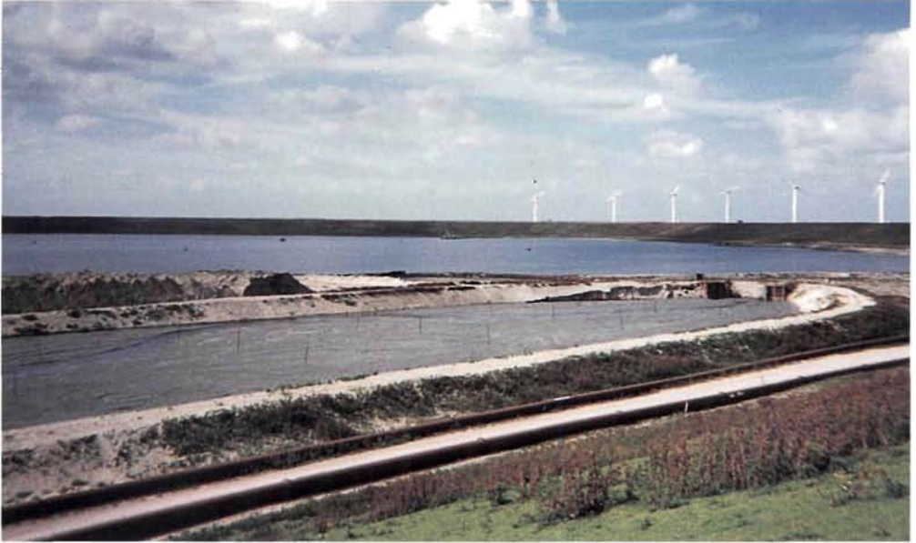
Dépôt à terre du Slufter (Pays-Bas) : au premier plan bassin de décantation et récupération des sables.
