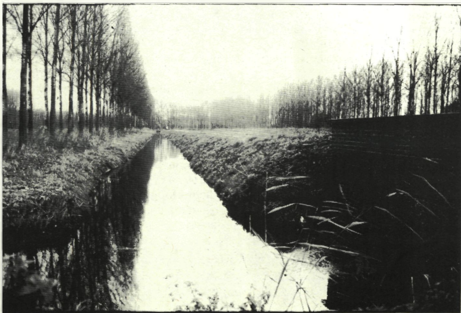
Rechtlijnige grachten zorgen voor een té snelle waterafvoer
