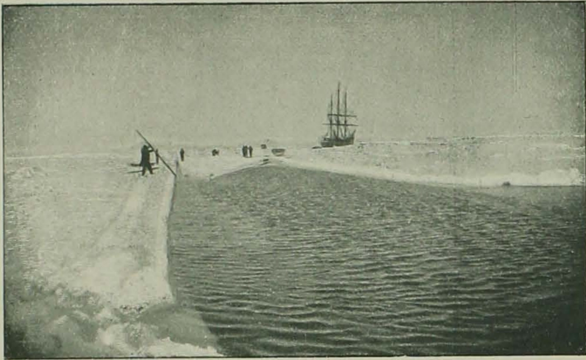
7. Travaux exécutés dans la Banquise. L'ouverture d'un Canal d'évacuation.
