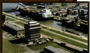
Bemande verkeerscentrale Zandvliet
