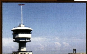
Bemande verkeerscentrale Zeebrugge
