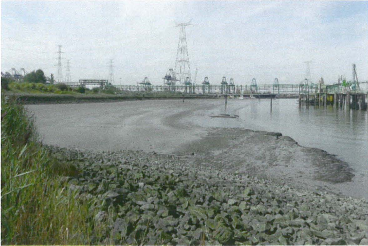
Figuur 5. Uitzicht over het slik bij Fort Liefkenshoek. Rechts in beeld de blootgespoelde turfbank en verspreide losse basaltstenen aan de dijkvoet (21/08/2019).
