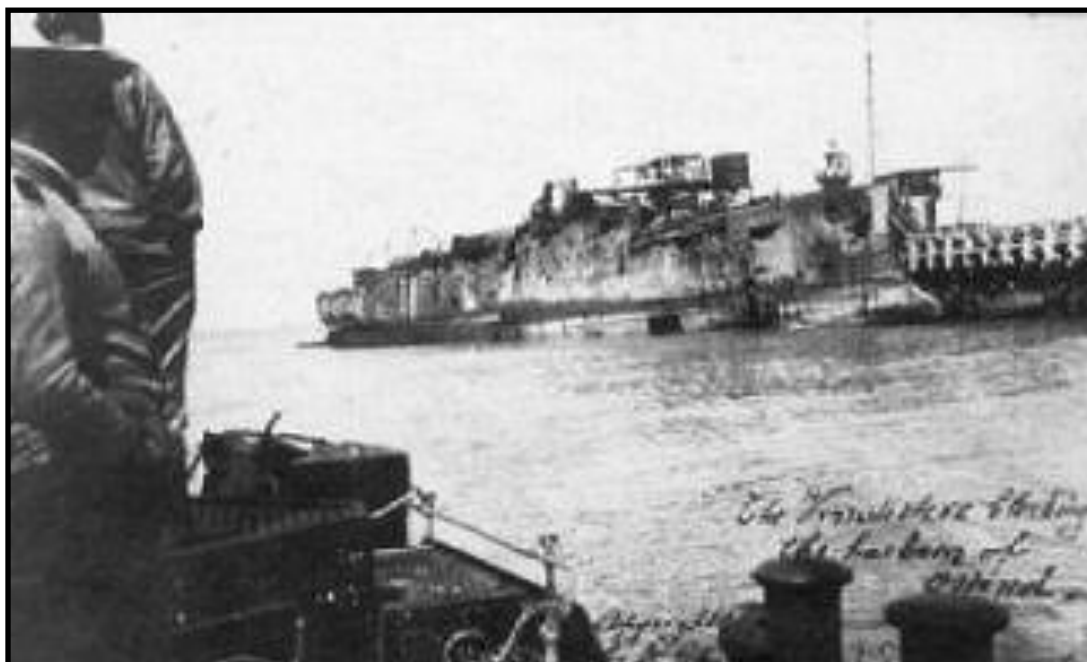
De totaal vernielde Vindictive tegen het Oosterstaketsel
