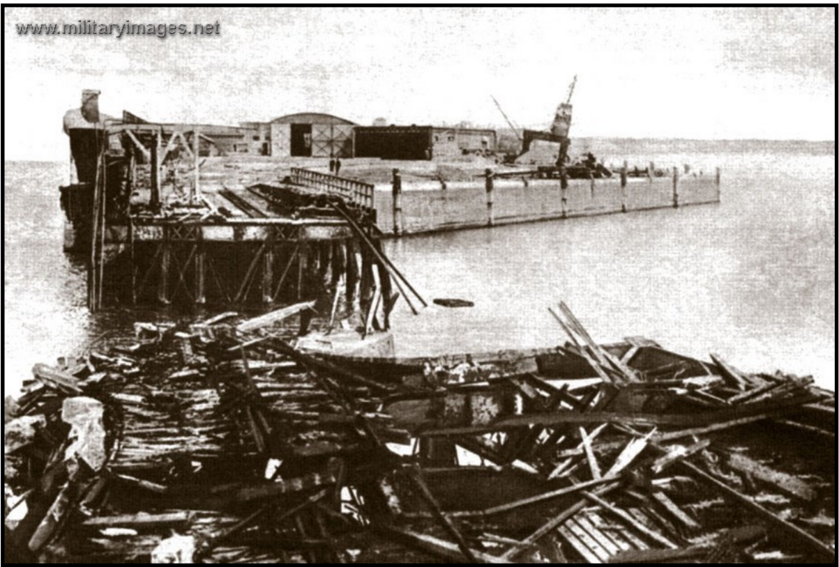
Vernielde viaduct door de ontploffing van de onderzeeër C3.
