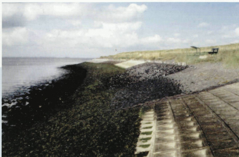
Experiment 'Dijktuin 2': het laat zien dat de begroeiing op de dijkglooing per oeverbekledingsoort varieert.
