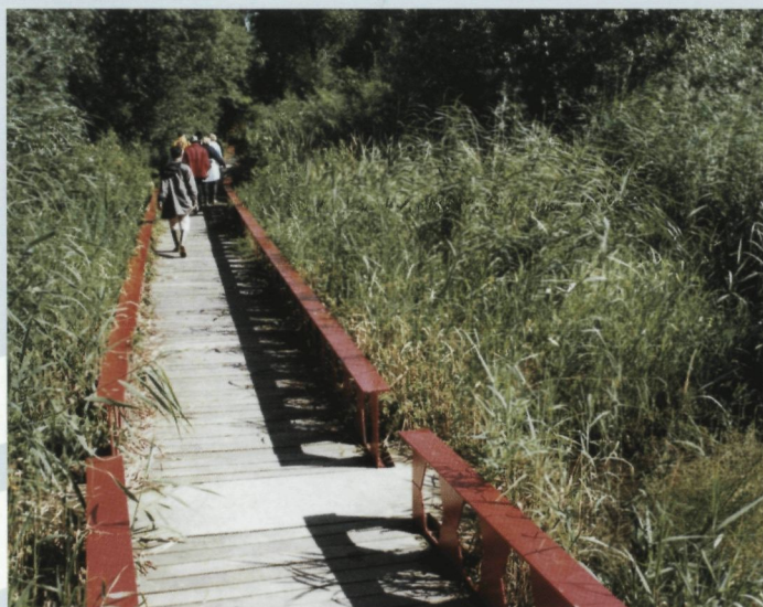
Plankier door rietmoeras in Ruigebosch bij Hoogvliet.
