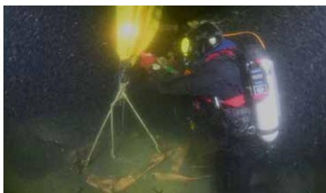
Afb. 18 Met behulp van een hefballon kunnen duikers de 200 kg zware pakketten onder water verplaatsen naar het bergingsnet.
