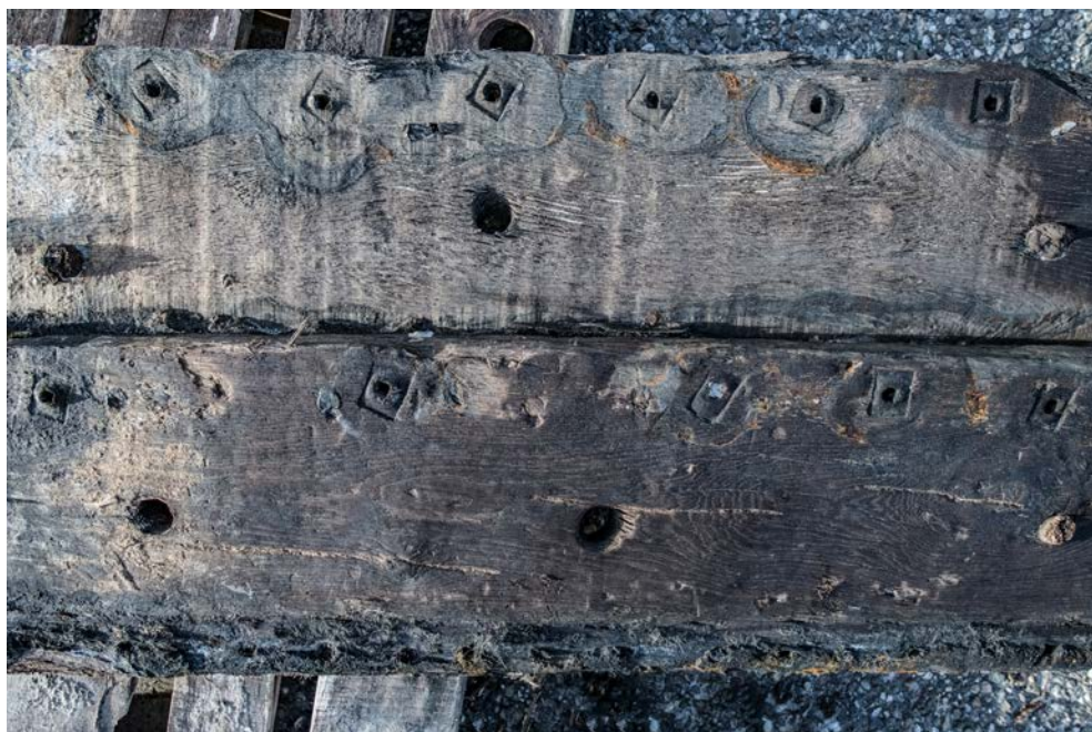
Afb. 5.11 In de bovenste gang (vnr V11-B) zijn in de achterste meters alleen klinknagels gebruikt.
