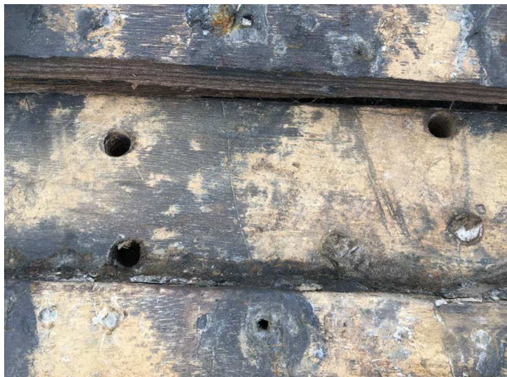
Afb. 5.13 Ingekraste hulplijnen voor de oprichting van de spanten.
