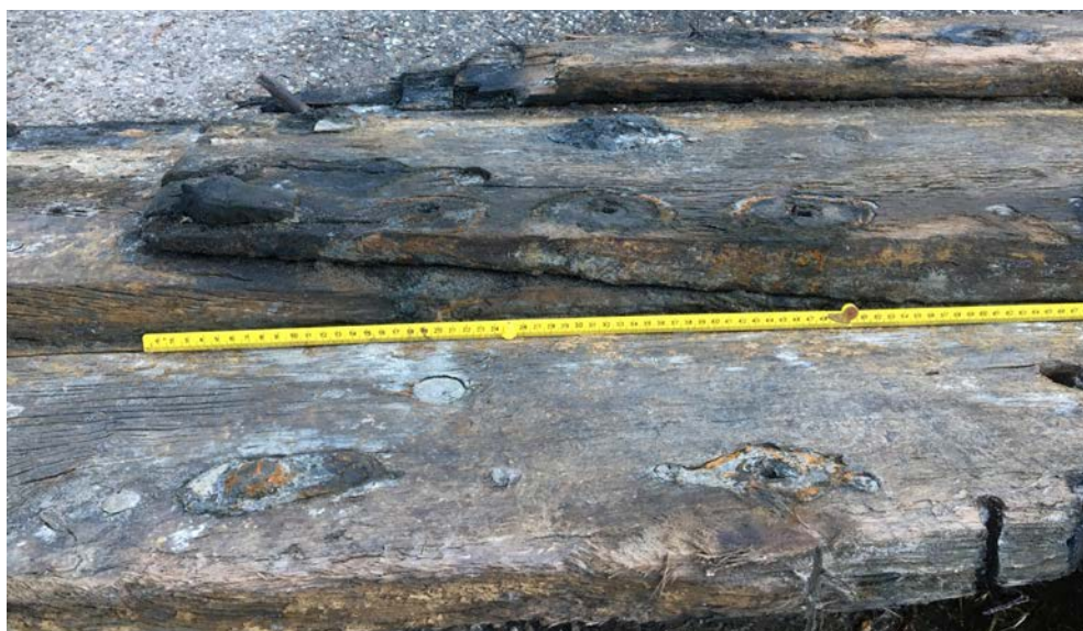
Afb. 5.12 Schuine las, in de lengte van de gang, in vnr V11-B (gang GG).
