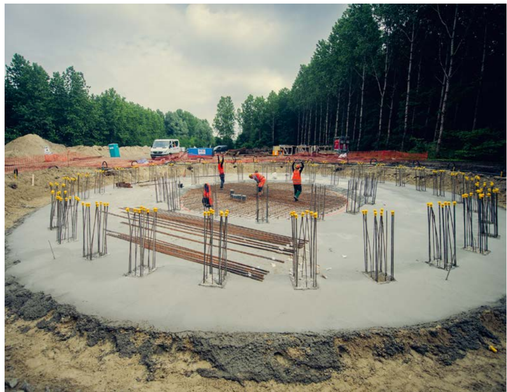
Afb. 3.1 Aanleg fundament windturbine Windpark Gent (juni 2016).
