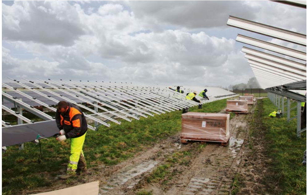
Afb. 3.3 Aanleg zonnepark met geheide funderingsconstructie bij Hoofddorp (foto: SolarEnergyWorks 2017).
