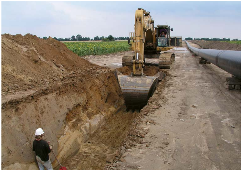
Afb. 3.4 Aanleg van een gasleiding met een diameter van 120 cm.
