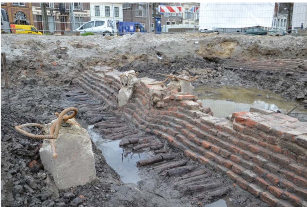
Afb. 4.5 De door moderne heipalen slechts in geringe mate verstoorte fundamenteën van het middeleeuwse Geertruidengasthuis te Kampen.
