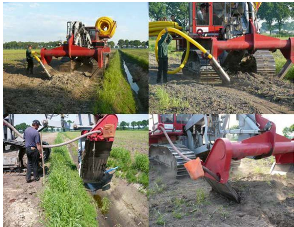
Afb. 2.7 Sleufloze aanleg van drainage te Ospel, provincie Limburg (bron: Stuyt 2013, fig. 68).
