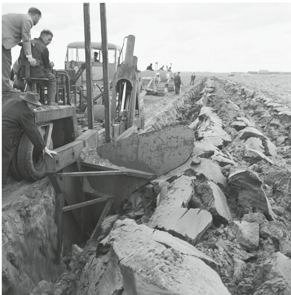
Afb. 2.14 Diepploegen in de Noordoostpolder in 1956 (bron: Nationaal Archief).
