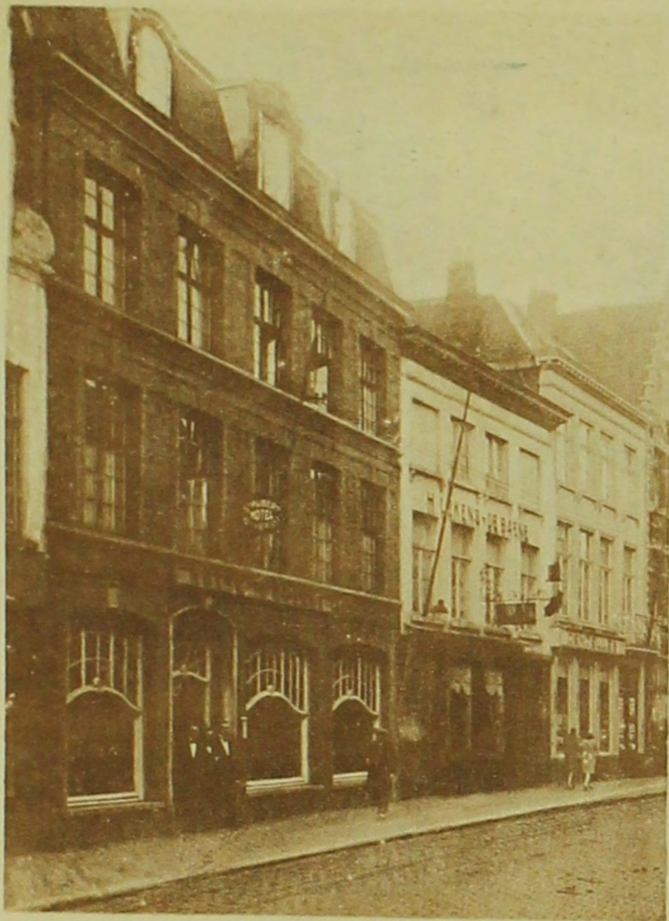
R. sud Sablon, 46, à l'HOTEL-REST. St-HUBERT. Tél. 316. Près de la gare. Confort moderne. Salle pour sociétés. Next to the station. Every comfort. Hall for societies. Beim Bahnhof, jeglicher Komfort, Halle für Gesellschaft.
