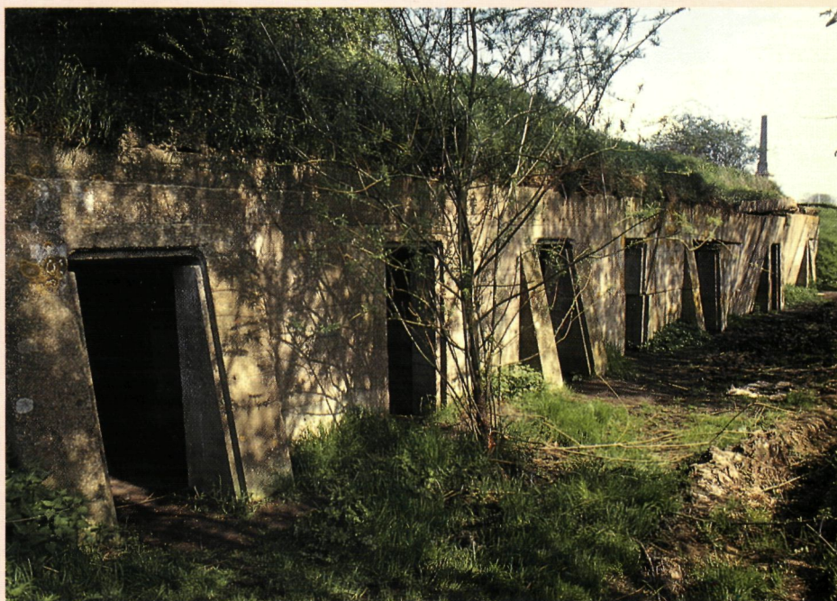
De kazematten aan het Ieperleekanaal in Ieper-Boezinge
