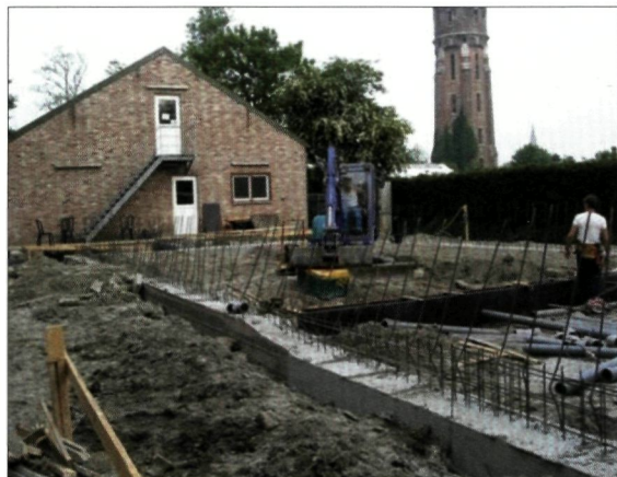
Afb. 44. Fundering van het gebouw voor kleine en middelgrote honden. Op de achtergrond het kattenverblijf.
