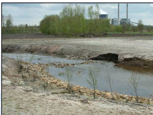
Figuur 7. Stroomversnelling en oeerversteviging in Maaskeien met aangeplante Zwarte els op de buitenoever.
