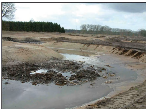
Figuur 6. Slib en rietzomen uit de oorspronkelijke loop van de Witte Nete werden overgebracht in de nieuwe bedding.
