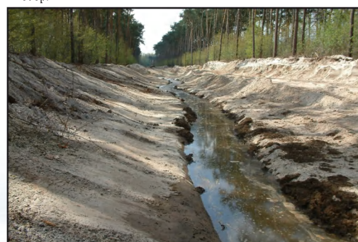
Figuur 3. In de heraanvulling uitgegraven loop van de verlegde Voorste Nete met aangevoerd slib uit de oorspronkelijke beekloop.
