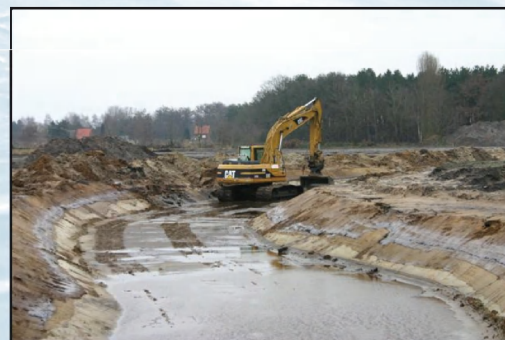
Figuur 5. Het nieuwe meanderende beekdeel van de Witte Nete wordt uitgegraven.
