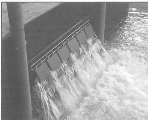
Figuur 8: detailzicht van de afwaartse rand van de kokers met terugslagkleppen
