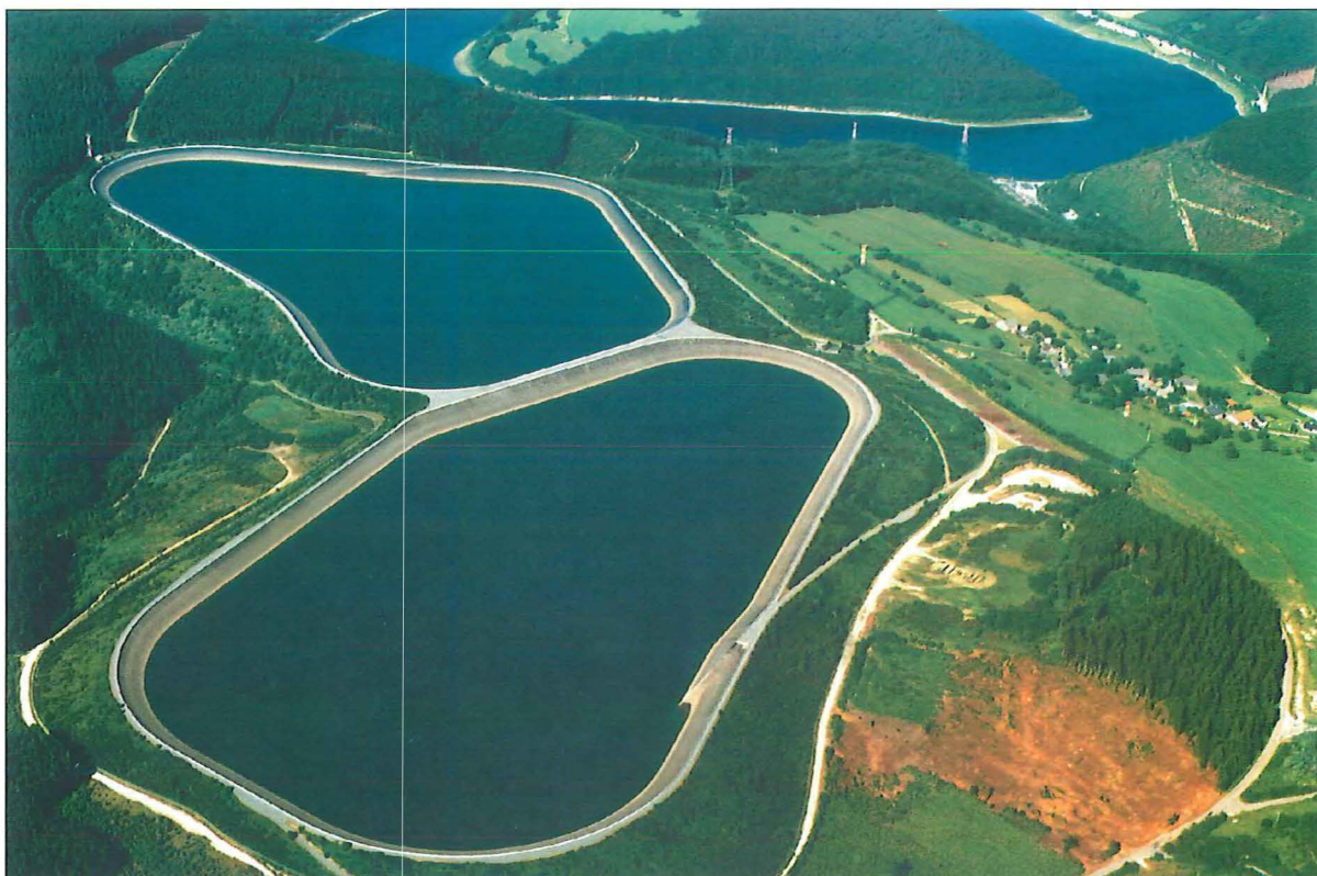
Bovenbekkens van Coo, die illustreren dat het mogelijk is grote hoeveelheden water op te slaan in periodes van hoogwaterstand. (foto ELECTRABEL)
