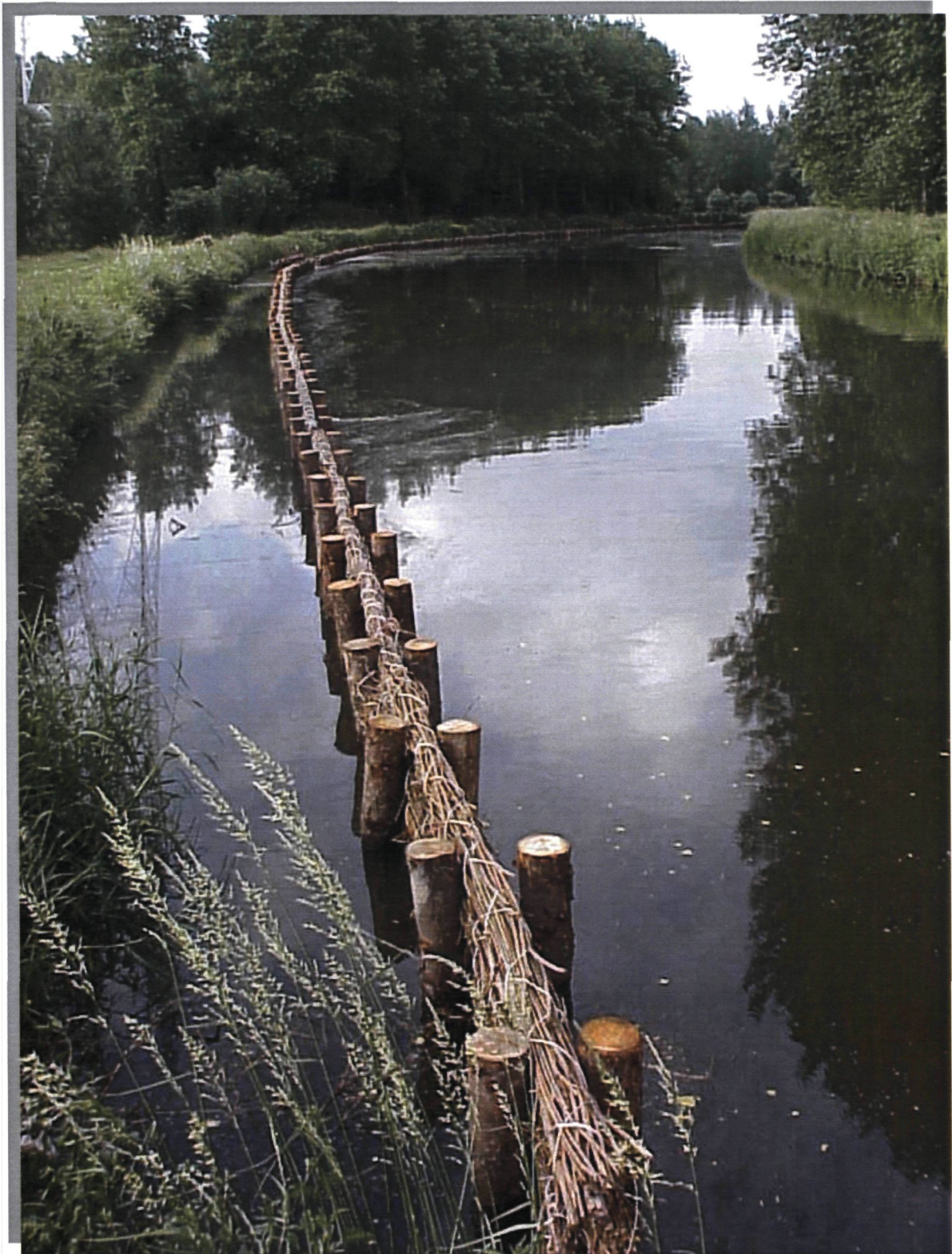
Natuurvriendelijke oever met harde vooroeverconstructie bestaande uit gevlochten wilgentenen.
