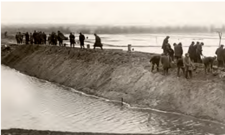
De nieuwe dijk bij Overasselt in aanbouw na de watersnoodramp in 1926.
