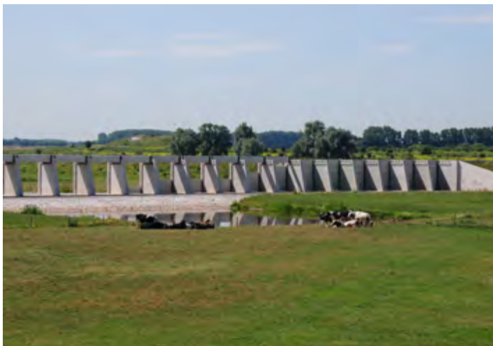
Regelwerk gebouwd bij Pannerden, in de buurt van het splitsingspunt van de Waal en het Pannerdens Kanaal. Het regelwerk zorgt bij hoogwater dat het water vanuit de Rijn verdeeld wordt over de beide riviertakken. Foto: Henk Monster, Wikimedia Commons, CC BY 3.0
