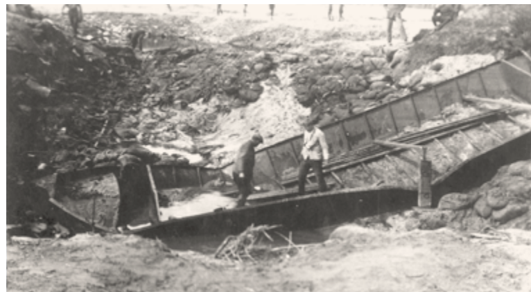
Dalfsen 1926. Arbeiders bij een afgezonken ijzeren bok in het dijkgat, ingezet om de stroming te remmen. De maatregel mislukte. Foto: Historische Kring Dalfsen, NL-DsHKD_104692, CC:BY-NC-SA
