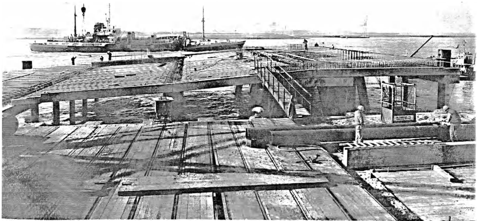
Het platform in aanbouw
