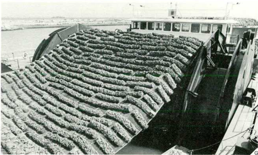
F. Tegelmattfabriek 1 rol 2 opslag betontegels 3 rollenbaan 4 kraan voor transport van kop- en staartbalken G. Grindwiepenmat H. Combinatie van Macoma, Donax I en Sepia bij het leggen van de grindwiepenmat
