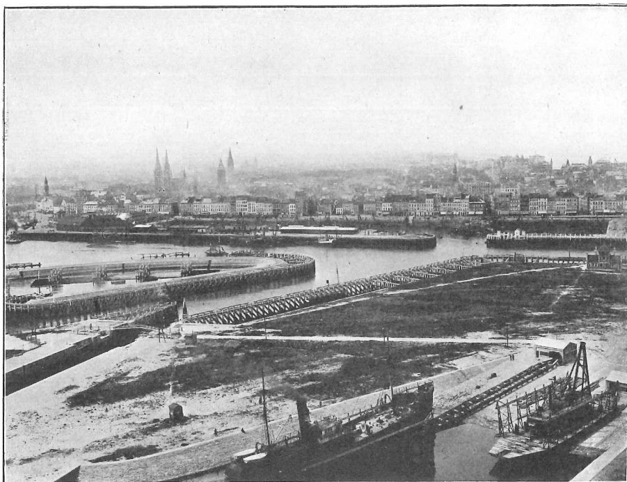
3. — ECLUSE MARITIME. CHENAL D'ACCÈS ET SLIPWAY.
