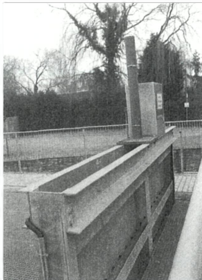
Archimedesvijs voor energieopwekking installatie van RITZ-ATRO in Rhede-Krechting (D) generator / schuifafsluiter
