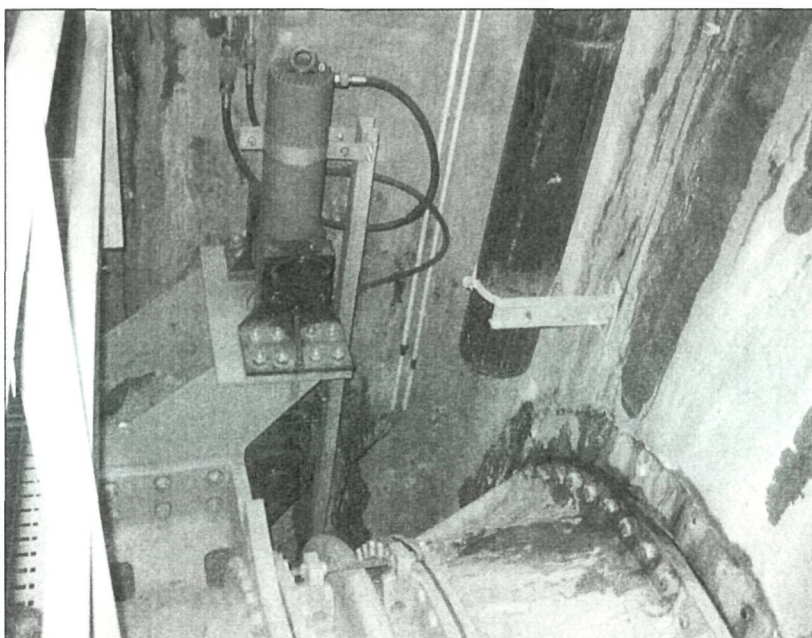
Sas No 1 : Aandrijving van vlinderklep
