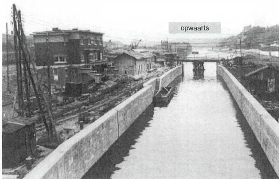
Bouw van sluis No. 1 in 1936
