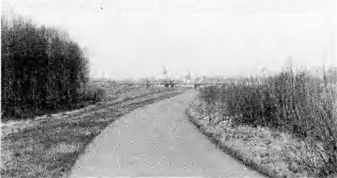
Scheldedijk op de rechteroever te Bornem: tijdens de dijkwerken werden taluds verflauwd, de kruin verbreed en werd op het riviertalud een breuksteenlaag aangebracht tot op de kruin.
