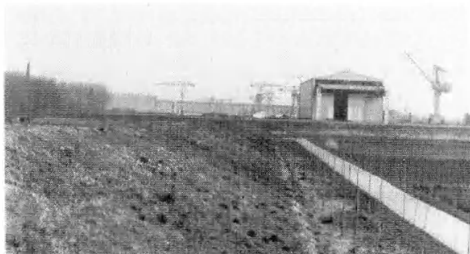
Ringdijk van het overstromingsgebied te Tielrode: om veiligheidsredenen mogen geen houtige gewassen op de dijk geplant worden. Daarom werd een landschapsintegrerende beplanting op de uitbatingstrook aangebracht.
