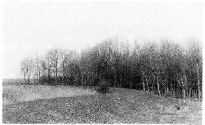
Scheldedijk op de linkeroever te Temse, tegenover Bornem, waar nog geen dijkwerken werden uitgevoerd.
