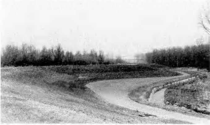
Scheldedijk te Bornem. De dijkverbreding ging hier gepaard met de aanleg van een uitbatingsweg met uitwijkingsstrook en van een met betonelementen verstevigde langsracht.
