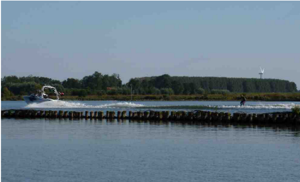
Foto 4.1: Het rijshout van de dammen zakt in de loop van het seizoen steeds verder in. Omdat ze elk jaar na het groeiseizoen worden vernieuwd, staan ze er in juni-juli op hun slechtst voor.
