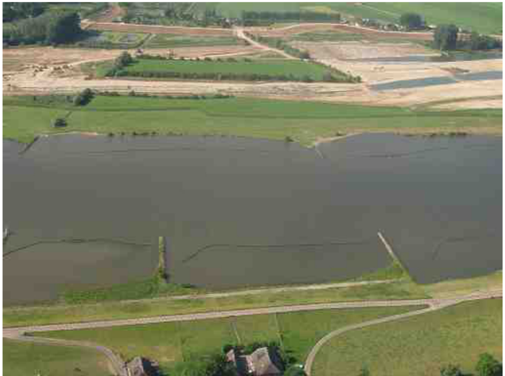
Foto 3.7: De vooroevers vanuit de lucht vanaf de noordzijde. Aan de overzijde is de herinrichting van de Everdingse waard in volle gang.
