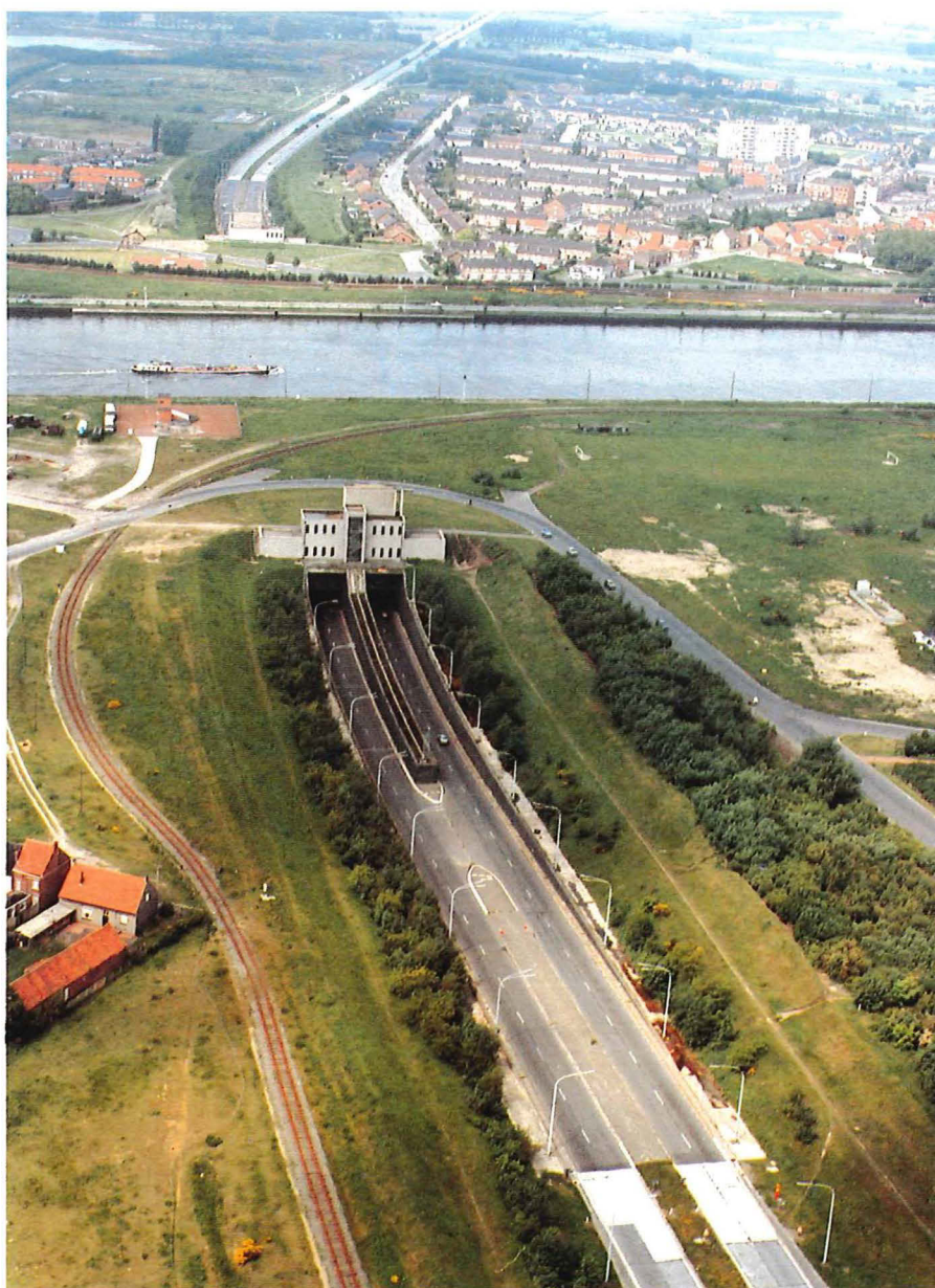
Le Canal maritime vers Gand - Le tunnel de Zelzate sur la voie rapide Anvers-Knokke (vue en direction de la côte) - A l'avant-plan, les installations de ventila- tion sur la rive droite.
