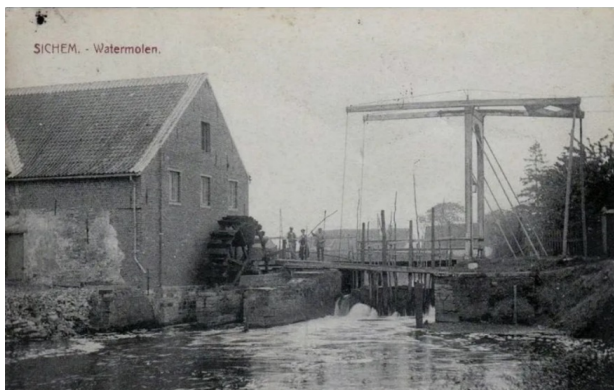
Afb. 9 De Grote Molen bij Zichem is een onderslagmolen op de Demer die is gebouwd halverwege de achttiende eeuw en diende als korenmolen. Deze molen was onder meer het decor voor de verfilmingen van 'De Witte', het bekende boek van Ernest Claes.
