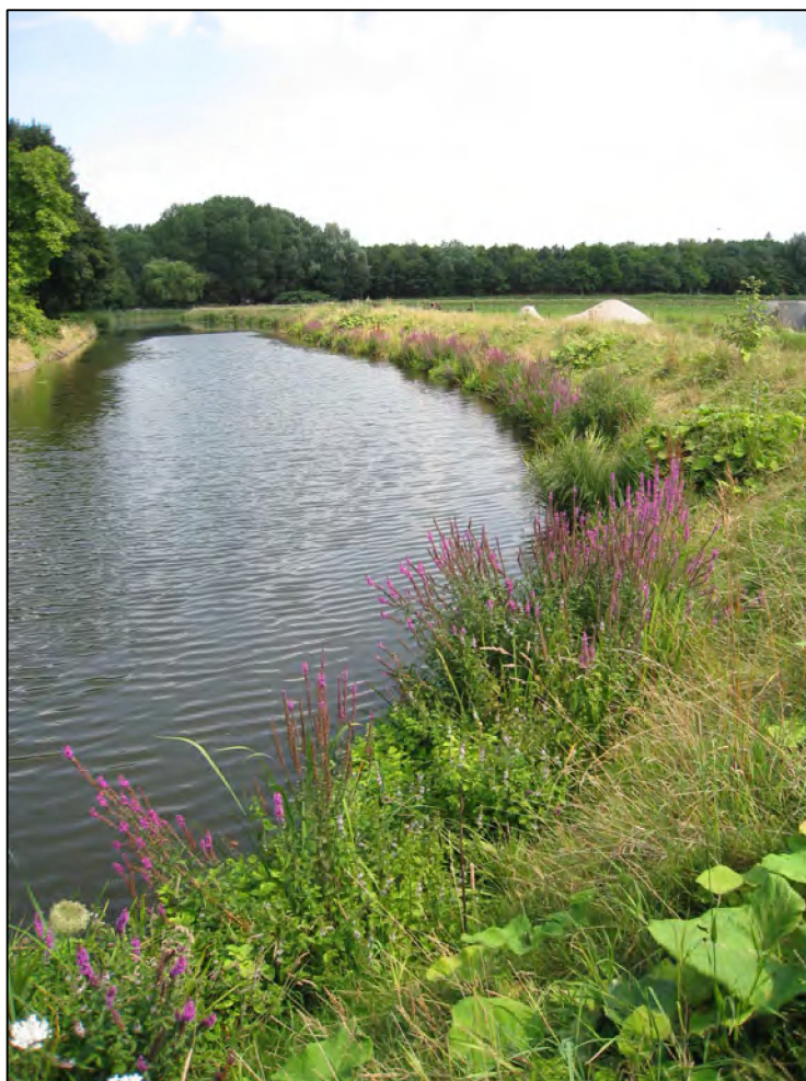
Foto 10. Voorbeplante kokosvezelmatten stroomopwaarts de Heirbaanbrug (LO) met een 8/4 helling
