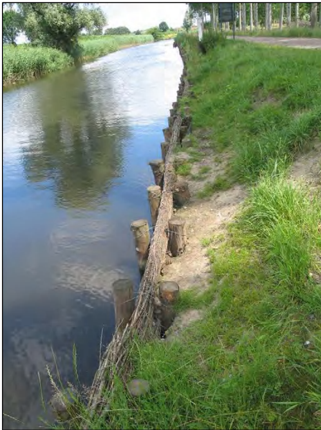
Foto 26. Constructie van palen en wiepen op het traject Coudenbormbrug-kanaal van Stekene
