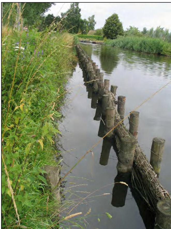
Foto 27. Constructie met palen en wiepen en plasbermen op het traject Coudenbormbrug-kanaal van Stekene (RO)
