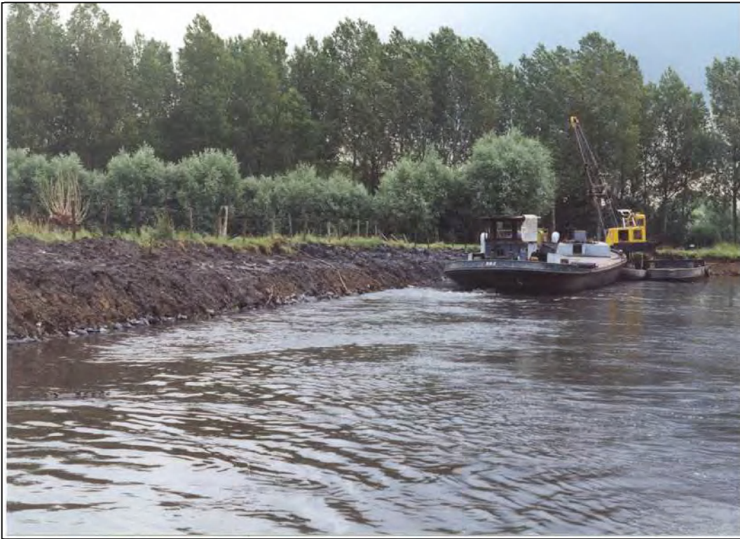
Foto 3. Herprofilering van de oevers bij de inrichting op het traject Daknambrug-P. Heydensveer (RO).
