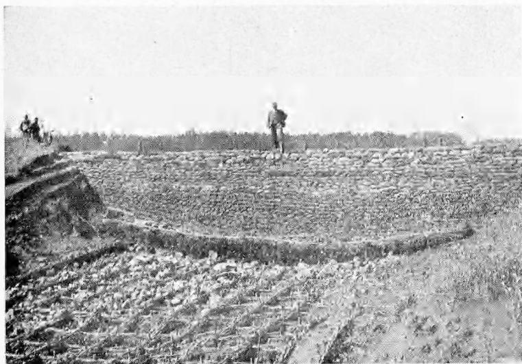
De Bres van Tielrode (1943) gestopt met zakken. De bekleeding en taluds moeten nog verwezenlijkt worden.
