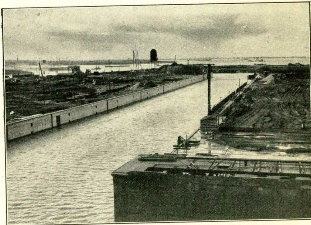
FIG. 1. — L'ÉCLUSE MARITIME BAUDOUIN À ANVERS. Photo R. Anthoine. Vue d'ensemble de l'écluse, prise le 19 mars 1955, après sa mise en eau. Au premier plan, la porte flottante amont.
