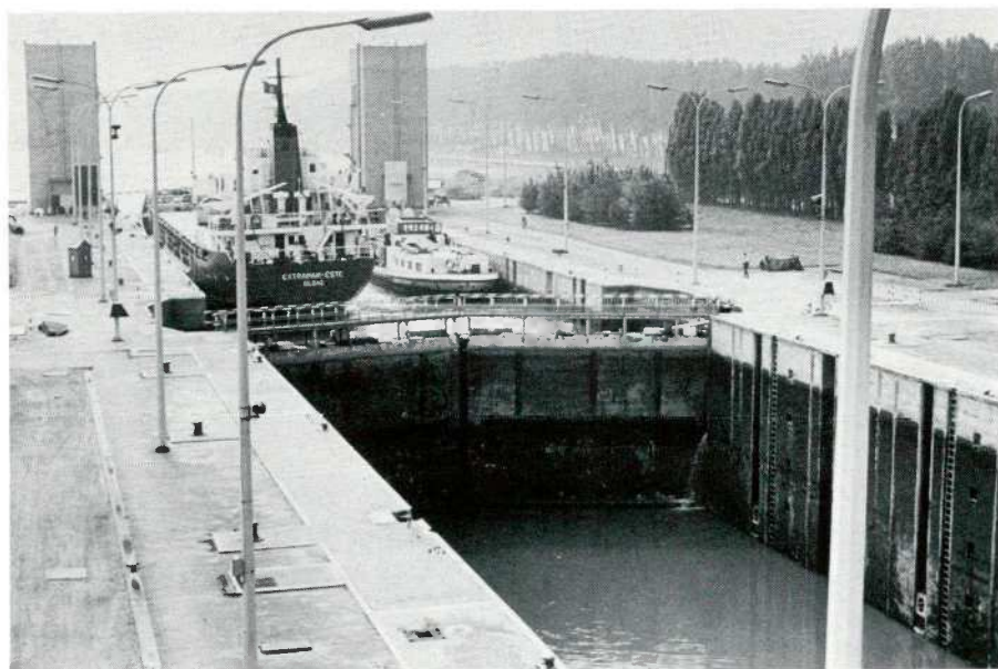
Vue d'ensemble de l'écluse de Zemst - Portes intermédiaires.
