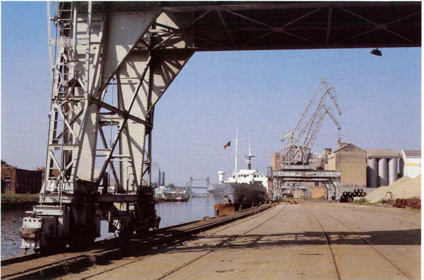
Vue d'ensemble de l'avant-port
