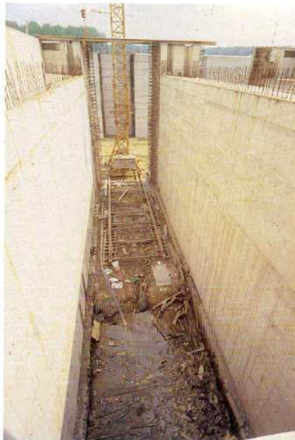
Mur de retour-aval
