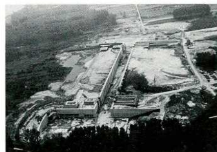
Vue d'ensemble de l'écluse de Hingene.
