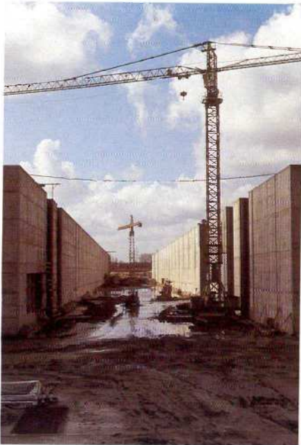
Chambre de porte.
