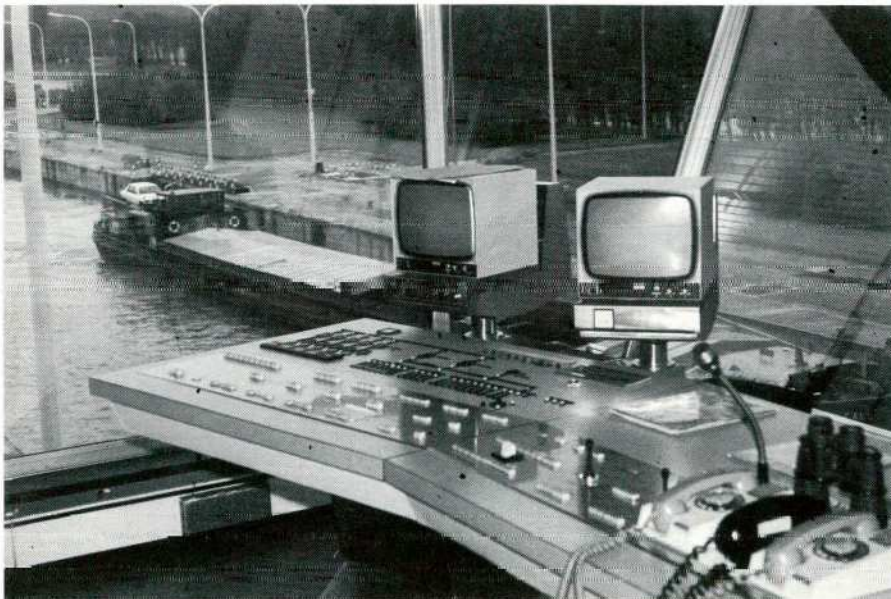
Electromechanische uitrusting van de sluis van Zemst - Bedieningspaneel.
