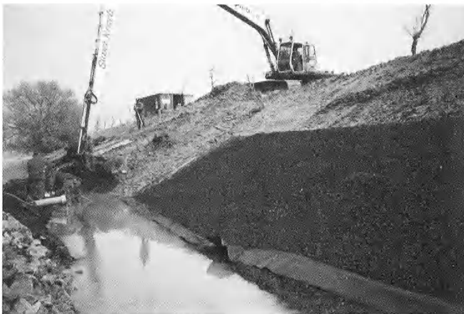
Foto 4. — Bescherming van het verharde achtertalud d.m.v. gevezelde open steenasfalt op geotextiel.
