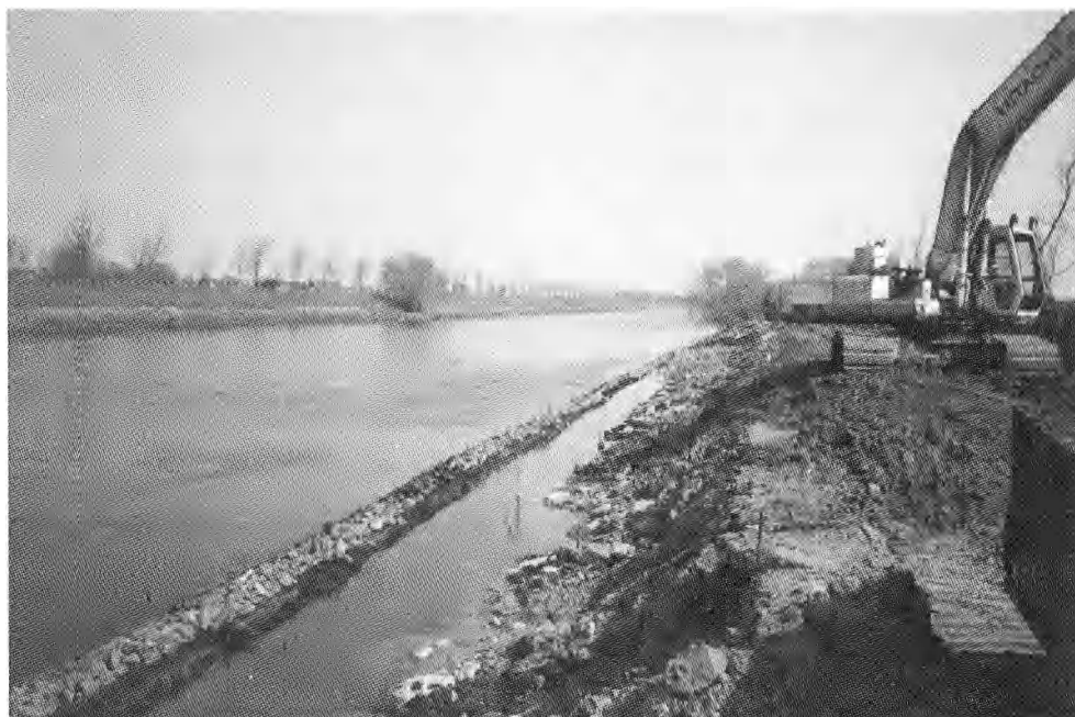
Foto 1. — Aanleg van de vooroever met zandasfalt, breuksteen en gietasfaltpenetratie.
