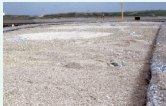
Op de Splitsingsdam in de monding van de Nieuwe Waterweg bij Hoek van Holland werd begin 2000 een broedgebied ingericht voor Visdieven. Het aangebrachte materiaal (grind en schelpen) wordt op zijn plaats gehouden door een ring van "schanskorven" (met stenen gevulde gazen constructies) (Floor A. Arts).
