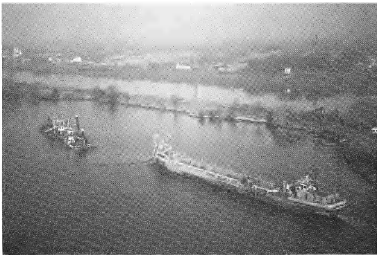
Fig. 3. — De veegzuiger (sweepdredger) aan het werk op het Brussels Zeekanaal.
