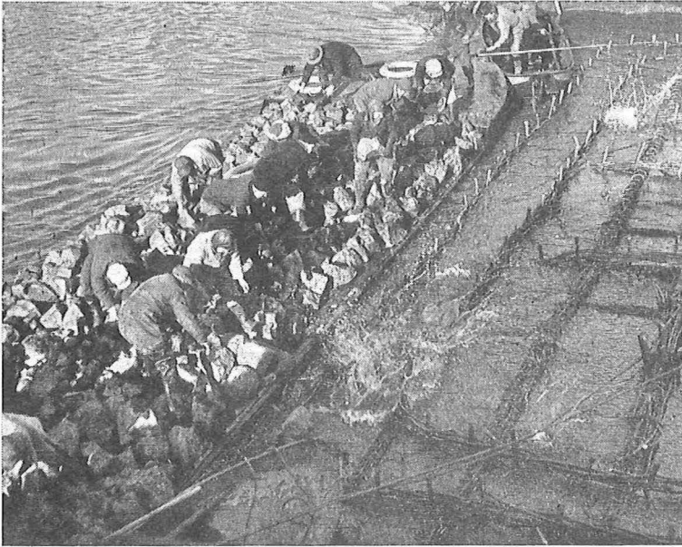
met stenen zinkstukken belast...
