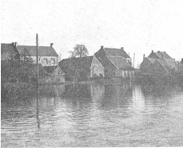
Het water blijft staan. Huizen aan de Rupel- dijk en V. Kegelsstraat.
