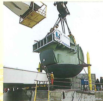
Het eerste bolscharnier is in februari 1995 hangend in een bok vanuit Krimpen aan den IJssel naar Hoek van Holland gevaren en voorzichtig op zijn plaats gehangen.
