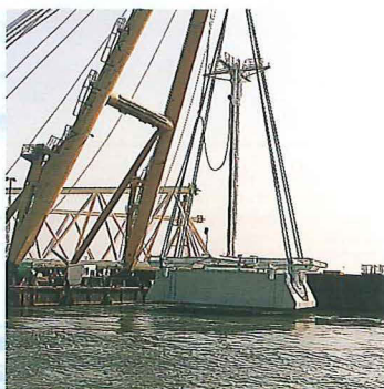
Plaatsing drempelblokken
