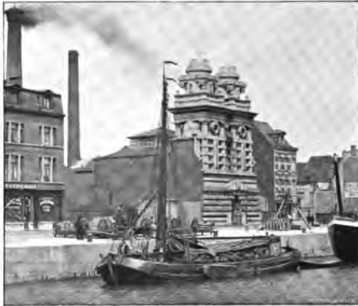
La maison Hydraulique.
