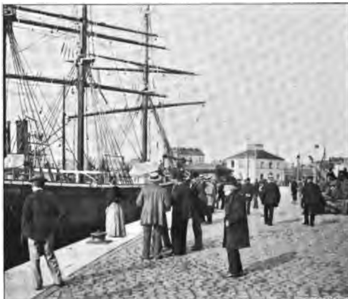
A l'entrée des bassins.
