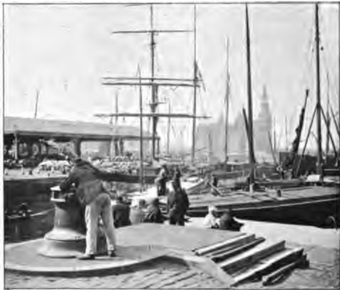
A l'entrée des bassins.
