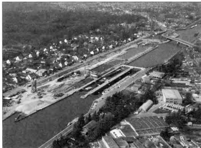
Foto 3: De nieuwe sluis te Wijnegem in aanbouw op het Albertkanaal. Een vermindering in droge periodes van het debiet dat te Monsin via het Albertkanaal afgetapt wordt van de Maas, kan een wezenlijke bijdrage leveren tot de problematiek van de Waterverdragen.
