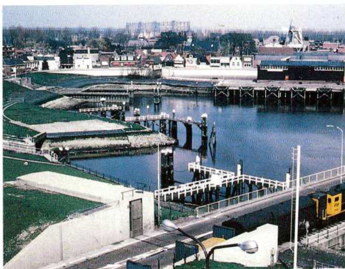
Coupure Delfzijl in geopende positie. De haven terreinen zijn nu makkelijk toegankelijk.
